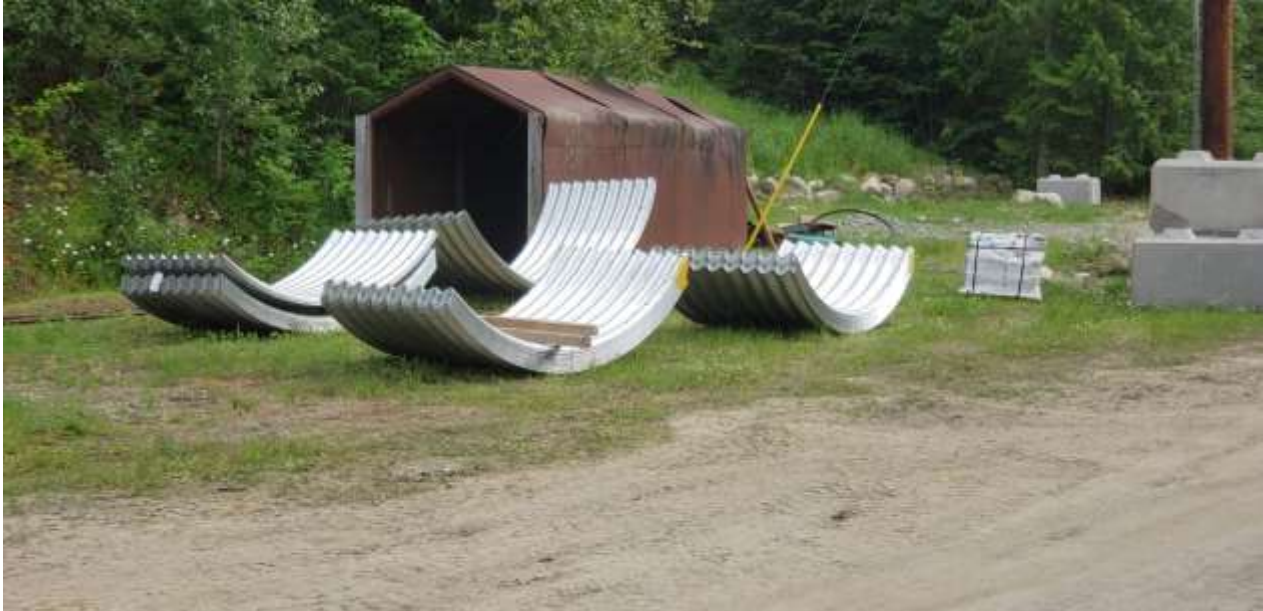
Mine Kenville: Stahl-Abzugskanal für das neue 257-Portal
