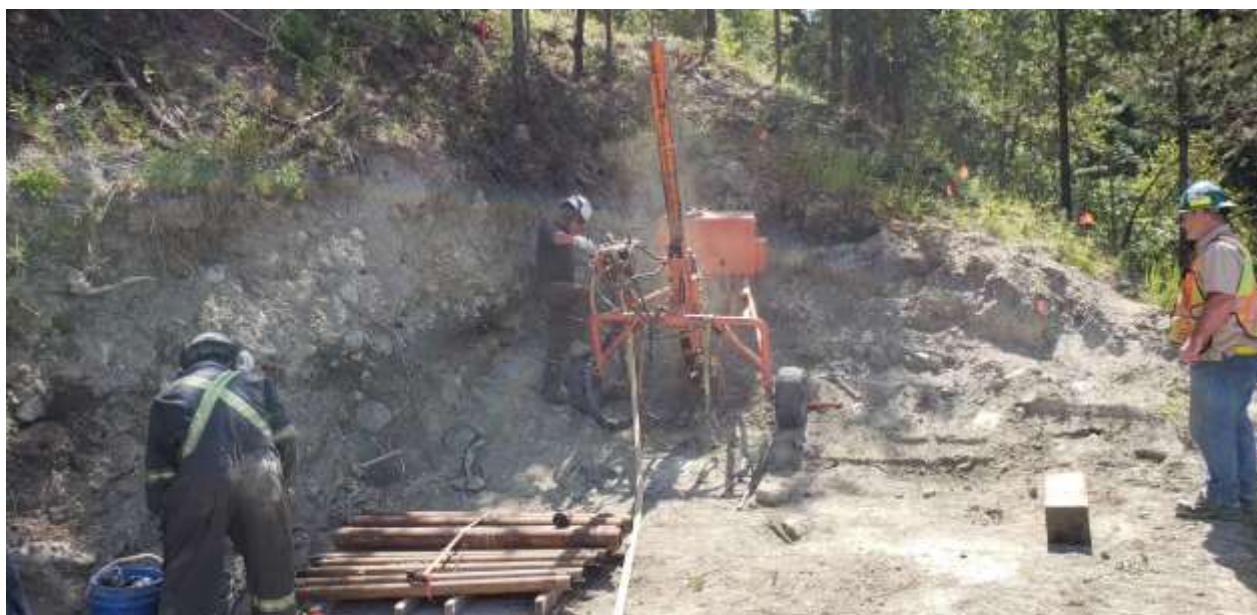
Mine Kenville: Geotechnische Bohrungen zur Sicherung der Deckschicht
