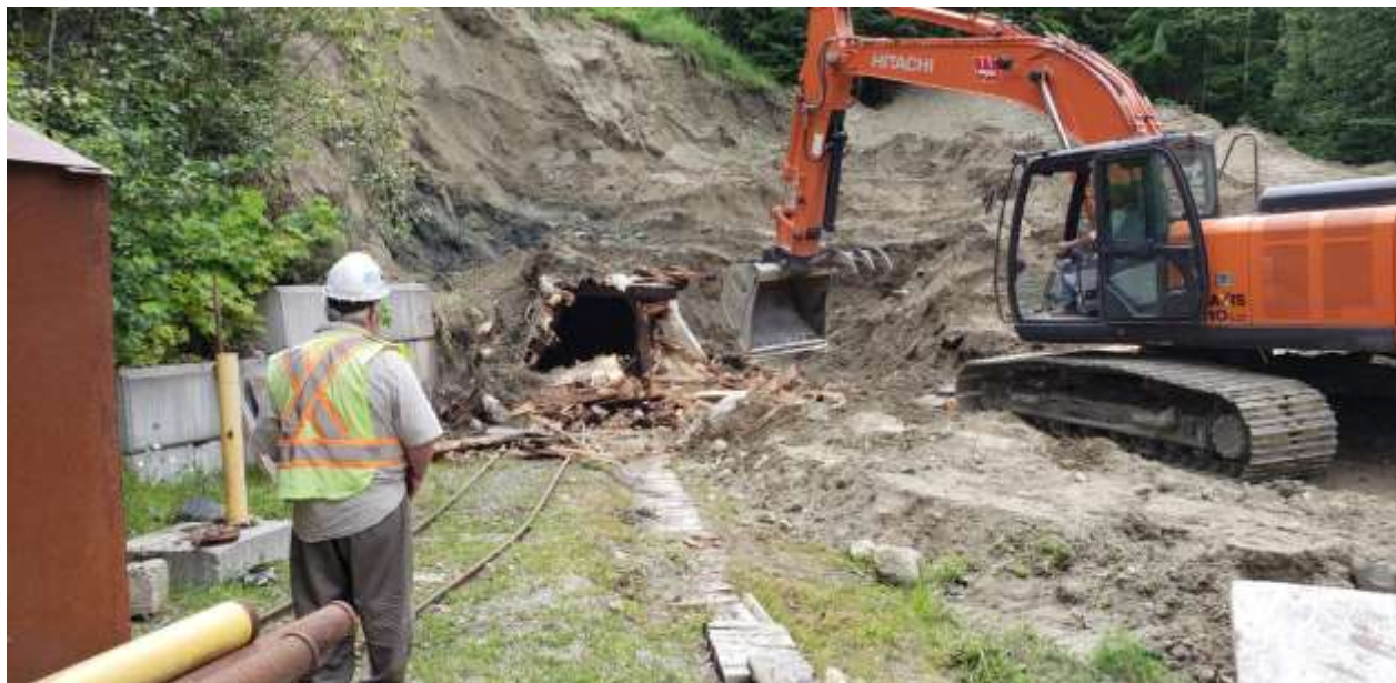
Mine Kenville: Aushubarbeiten im Bereich des 257-Portals
