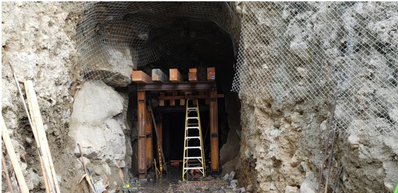
Foto der neuen Stahlgarnituren mit neuen Holzbalken.
