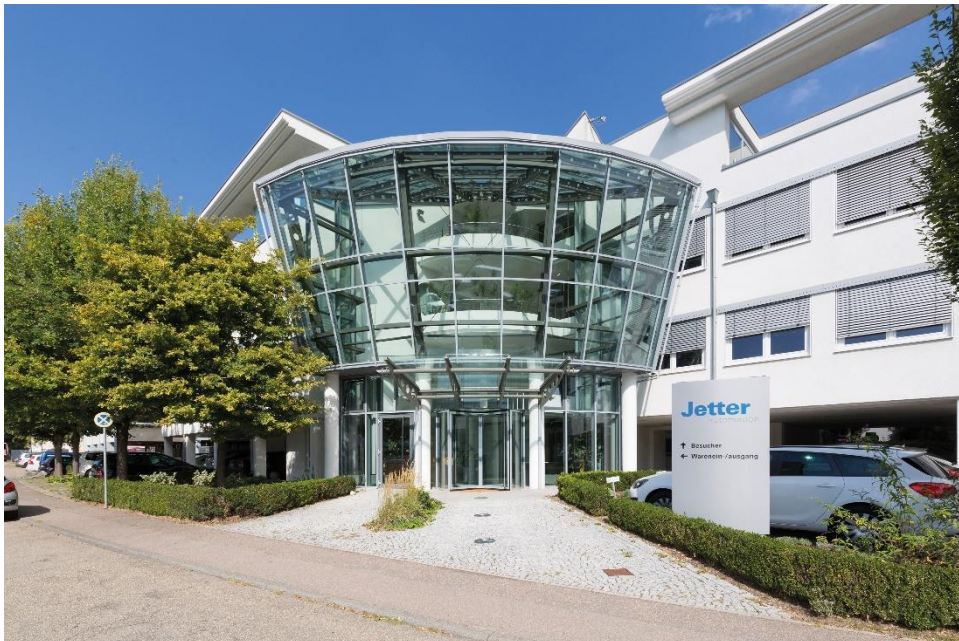
Jetter wird innerhalb der kommenden zwei bis drei Jahre den kompletten Supply-Chain-Prozess von Lenze Mobile Drives übernehmen. Auf die steigende Produktionsauslastung reagiert der Automatisierungsspezialist mit einer Anpassung der Kapazitäten am Hauptsitz in Ludwigsburg.
