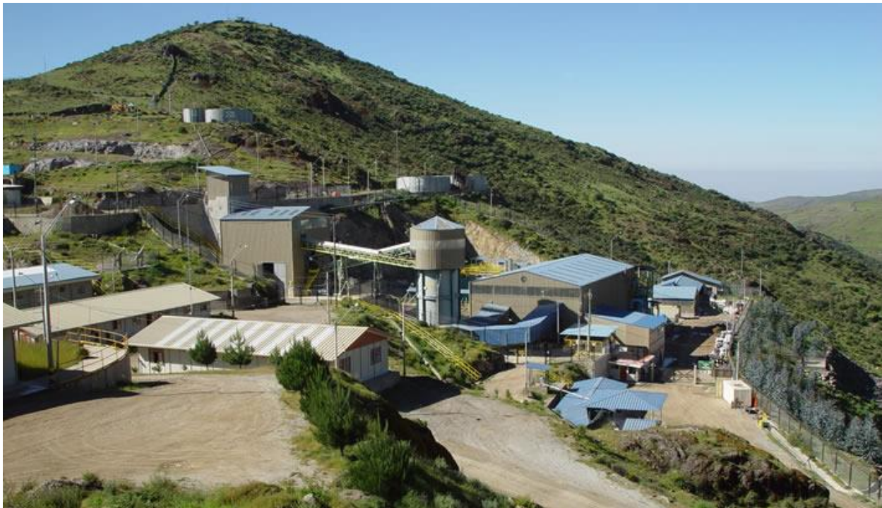
Bild 1. Die Anlage von Sierra Antapite
